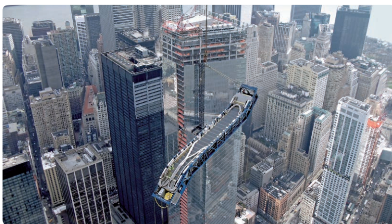
Fahrtreppe auf dem Weg zum Einbau ins One World Trade Center, New York (Quelle: thyssenkrupp)
