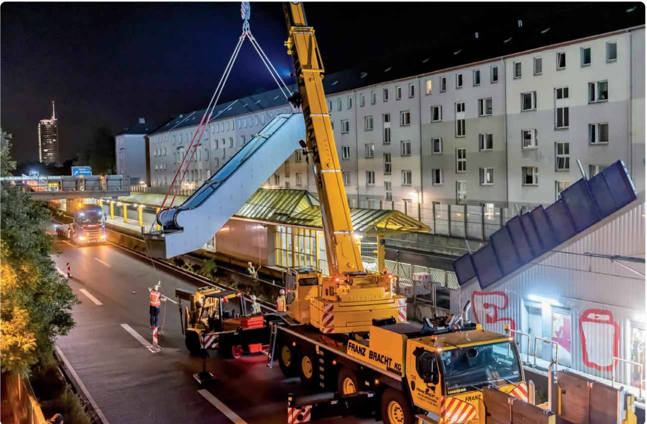
Eine der neuen 15 Meter langen und 12 Tonnen schweren Fahrtreppen wird nachts in Position gebracht. Schauplatz im August 2019 an der Haltestelle Savignystraße zwischen den gegenläufigen Autobahnspuren der A40 mitten in Essen. (Quelle: thyssenkrupp)
